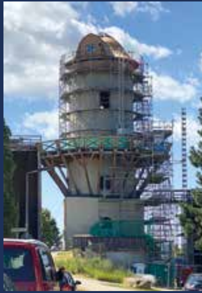
Aufsetzen der neuen Mühlenkappe
