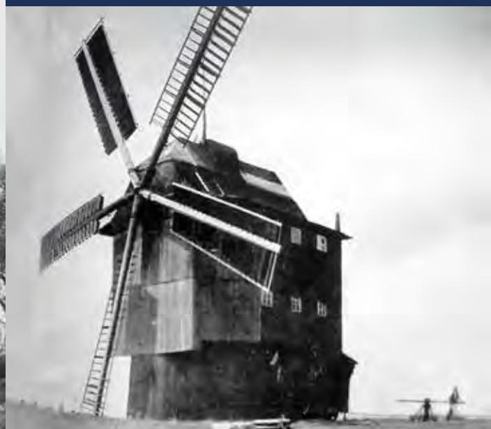
Eine fünfflügelige Paltockmühle mit einer Zugkette zum Drehen in den Wind
