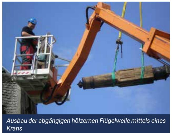
*Ausbau der abgängigen hölzernen Flügelwelle mittels eines Krans*
