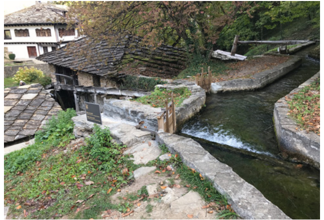
Wasserzufluß zu einer Wassermühle.
