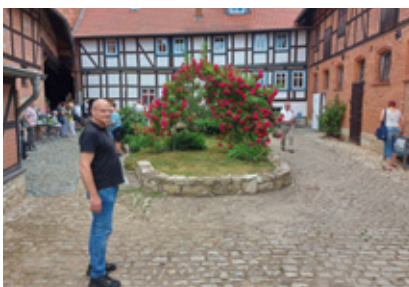
Der Innenhof des historischen Dreiseithofes Badersleben mit der Mühlengebäude in der Mitte des Dreiseithofes.
