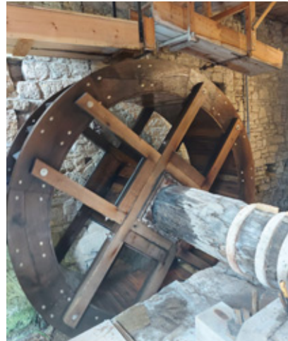
Das innenliegende Wasserrad der Wassermühle Badersleben.
