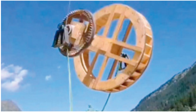
Das Mühlrad mit Antriebsrad auf dem Wellbaum beim Abheben in die Luft. (Foto: Glatzl)
