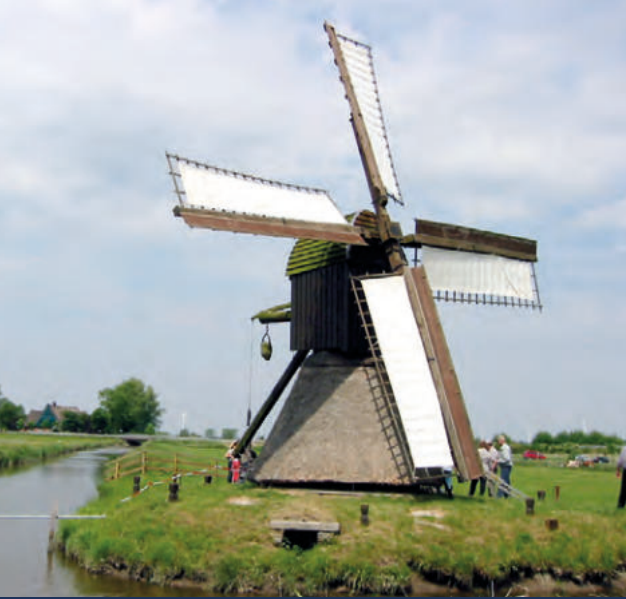
Bockwindmühle bei Honigfleth als Wasserschöpfmühle
