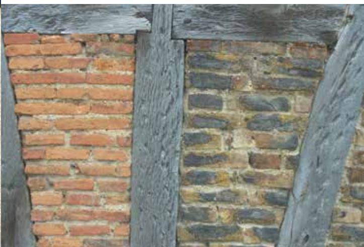
Ausgemauertes Fachwerk mit Backsteinen in der Enggasse in Bad Soden am Taunus
